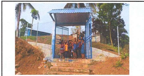
Foto 4: Finalización de la colocación de porton pintada
