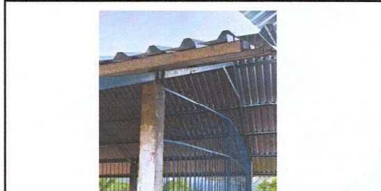
Foto 6: Finalización de colocación de balcones
